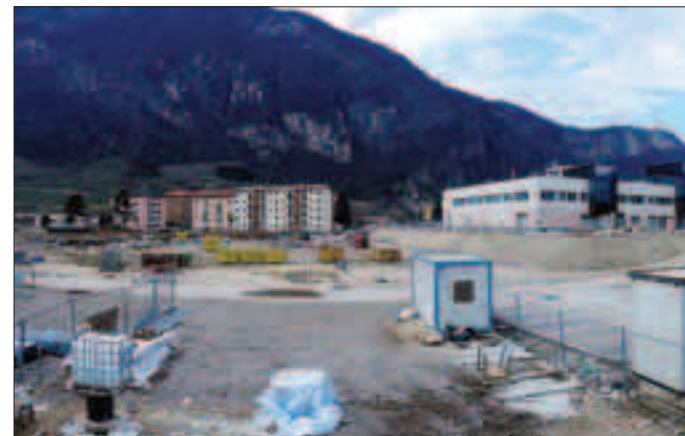
Il cantiere per il nuovo ospedale (fotoservizio Piero Cavagna)
