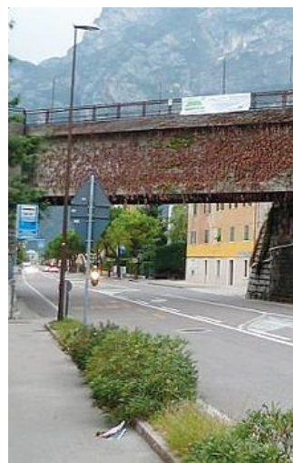
Ancora lavori in viale Trento
