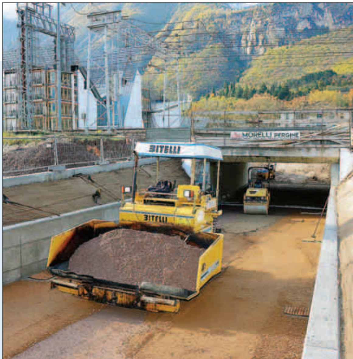
Buldozer e ruspe in azione per preparare l'asfaltatura (Foto PAOLO PEDROTTI)
