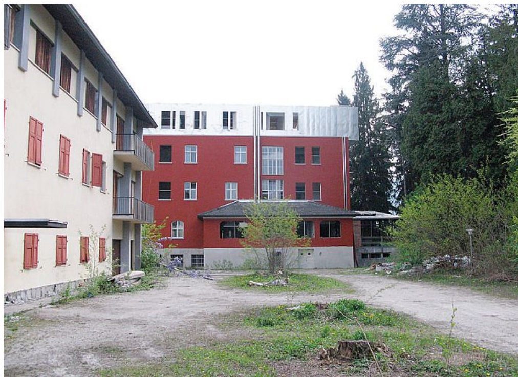
L'ex Hotel Seehof di San Cristoforo con, a sinistra, la dependance: due strutture da tempo abbandonate
