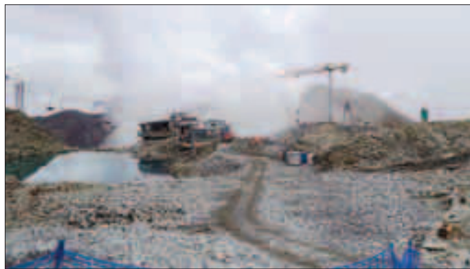
I lavori di realizzazione del nuovo impianto
