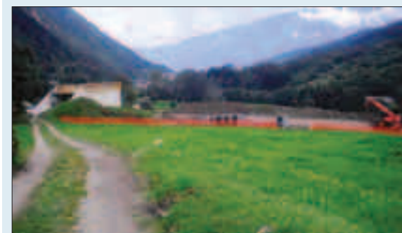
Ora l'orizzonte è chiuso dal cantiere della strada
