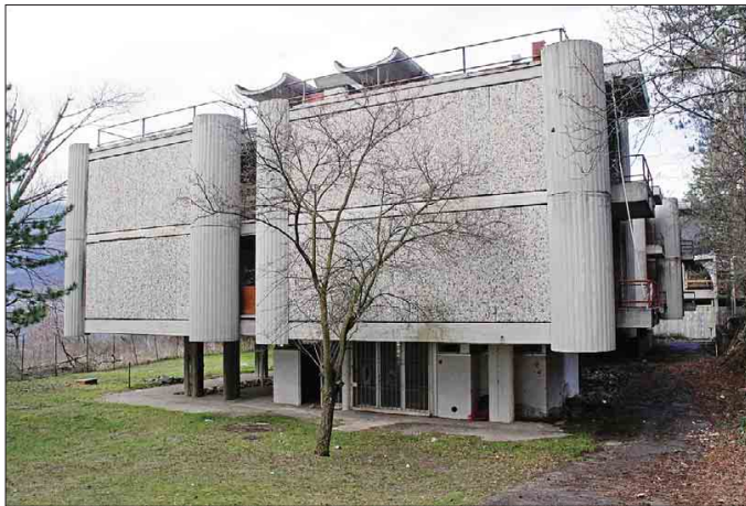
L'edificio ex Anmil, scheletro di cemento mai utilizzato in mezzo al verde del Bosco della città a Rovereto
