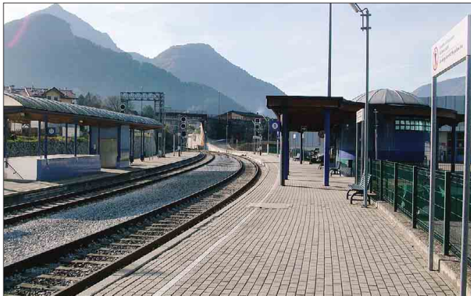
La stazione di Borgo Est della Ferrovia della Valsugana
