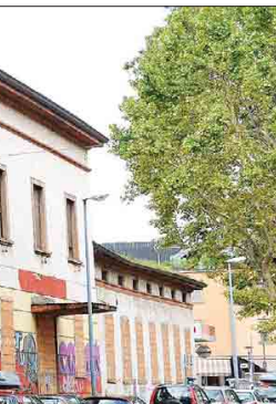
L'ex asilo di via Manzoni, sotto l'ex Almetal di Mori, due ecomostri che la Provincia intende far abbattere grazie alla legge sull'urbanistica firmata da Carlo Daldoss
