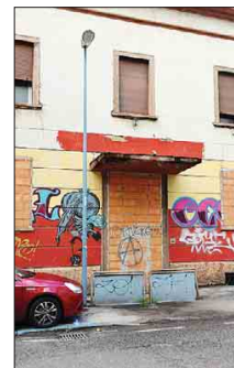
L'ingresso murato dell'ex Asilo
