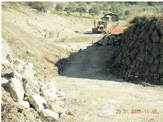
Il vallo che protegge Sarche e la statale dalla caduta di massi
