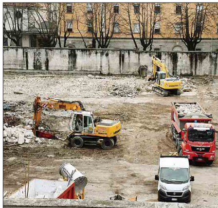
I lavori di demolizione delle baracche dell'ex carcere di via Pilati
