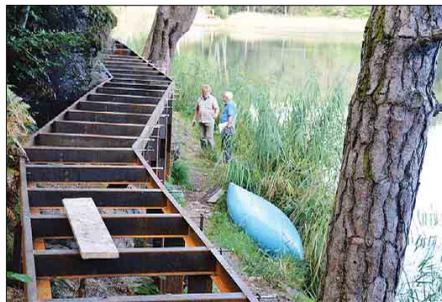
La struttura a sostegno del sentiero ovest: in putrelle di acciaio
