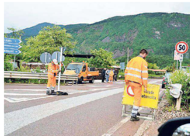
Gli operai del Servizio strade hanno collocato la segnaletica sulla Sp 76
