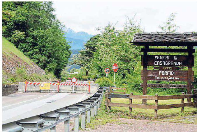
Le barriere new jersey sbarrano il passaggio sulla Sp 76 ad Albiano
