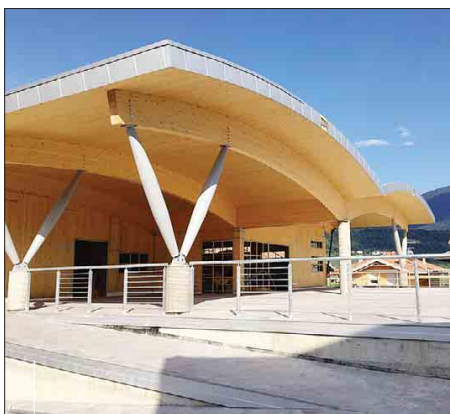
In alto, l'ex colonia Don Bosco di Passo Cereda e l'assessore all'urbanistica e agli enti locali Carlo Daldoss. A fianco, l'ex magazzino frutta di Portofino, demolito per fare spazio al nuovo centro polifunzionale (foto sopra). Sotto, l'ecomostro dell'ex Anmil a Rovereto
