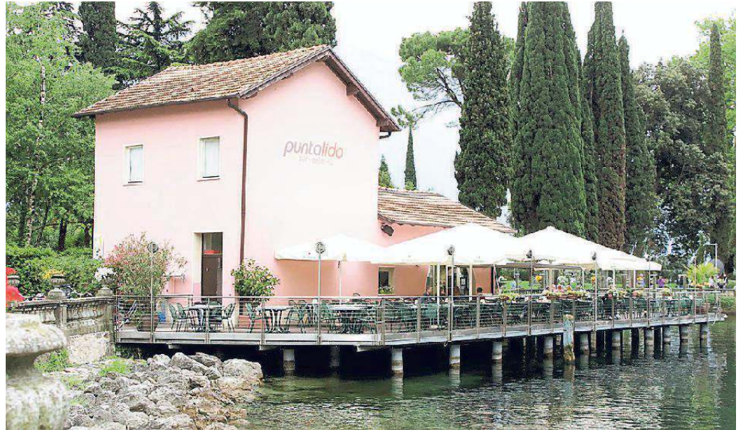
La gelateria di Punta Lido: il progetto della Lido Srl prevede la demolizione e rifacimento ex novo
