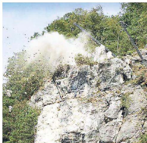
Prime esplosioni per demolire il diedro (F. Ivo Cipriani)
