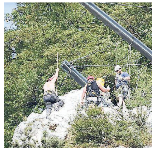
L'intervento degli operai nella parete sopra Mori
