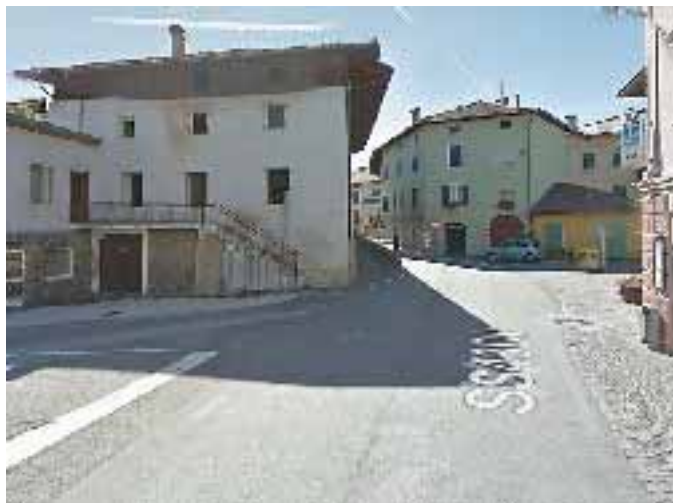
La strettoia di Romeno con gli edifici che saranno parzialmente demoliti
