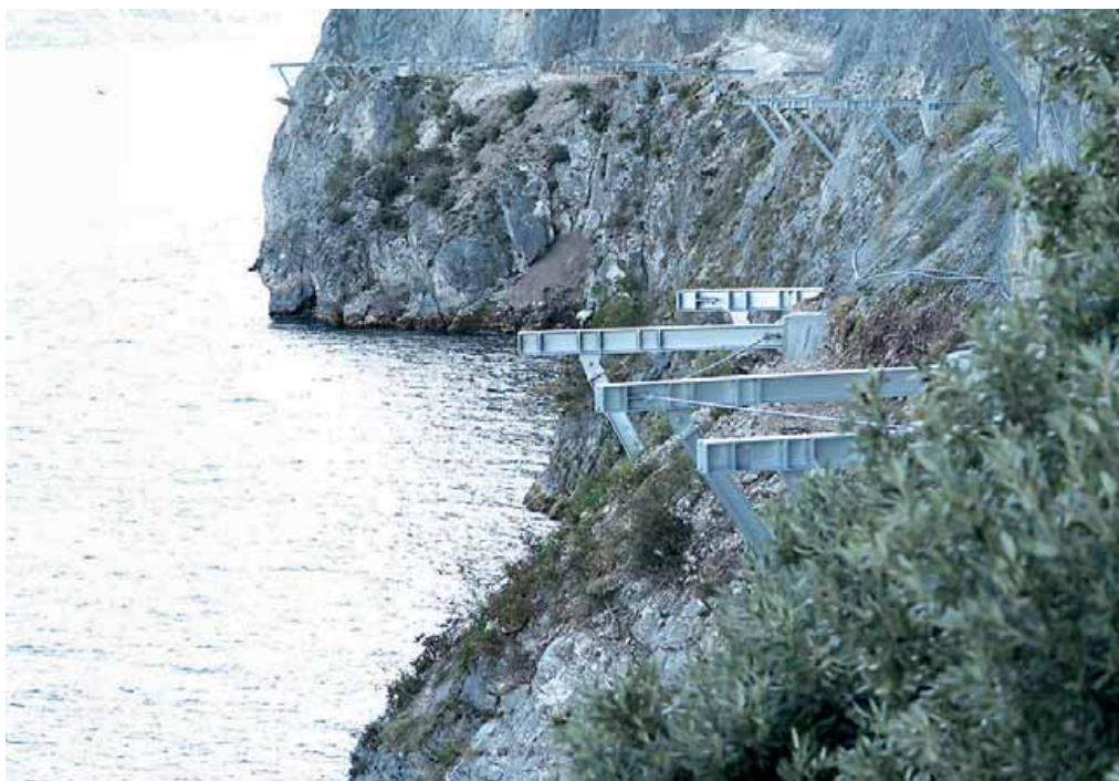
I lavori di realizzazione della pista ciclabile a sbalzo nel tratto fra Limone e Riva (foto Galas)
