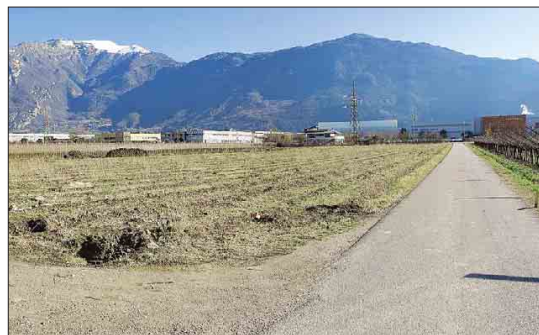
Una parte del tratto di via S. Isidoro interessato dai lavori per la nuova strada (Fotoshop)
