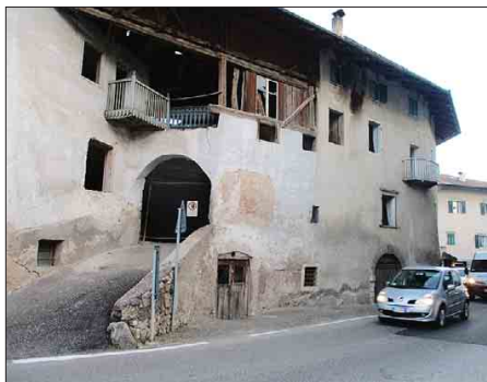
L'edificio che l'Amministrazione vuole abbattere per allargare la strada
