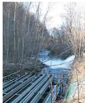
Rilascio dell'acqua della centrale
