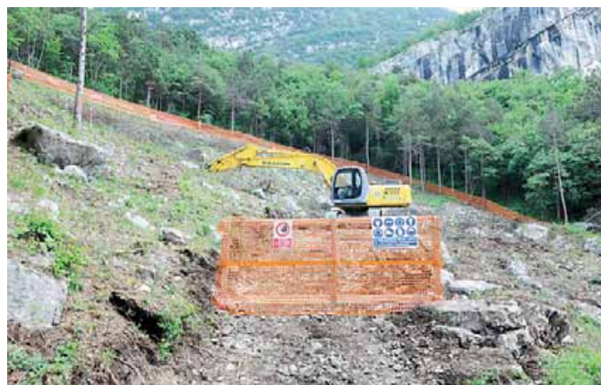
La ruspa che aspetta solo di cominciare a scavare nella roccia
