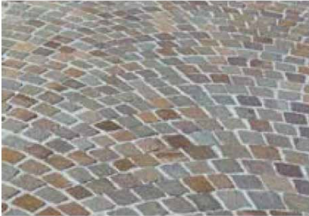
PAVIMENTAZIONE PIAZZA: pavimentazione con cubetti in porfido esistenti recuperati, ad archi contrastanti
