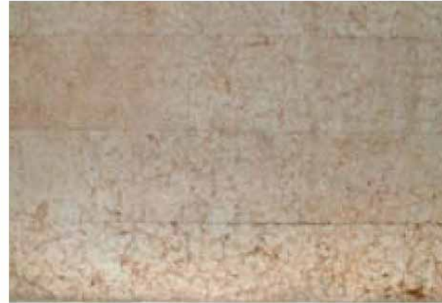
AREA INGRESSO AL CASTELLO: lastre in pietra rosa Trento
