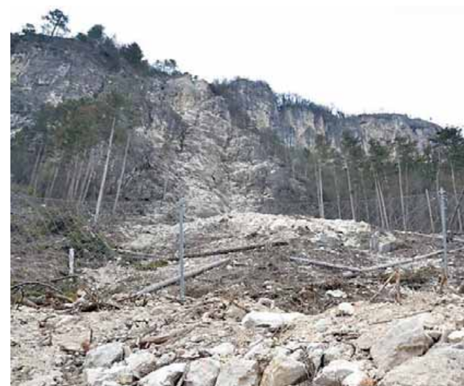
Lo spettacolo poco edificante della frana visibile dalla borgata
