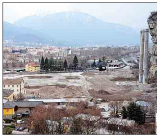
L'area ex Italcementi con le due ciminiere rimaste
