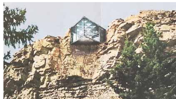
Uno dei punti panoramici realizzati in corrispondenza delle stazioni
