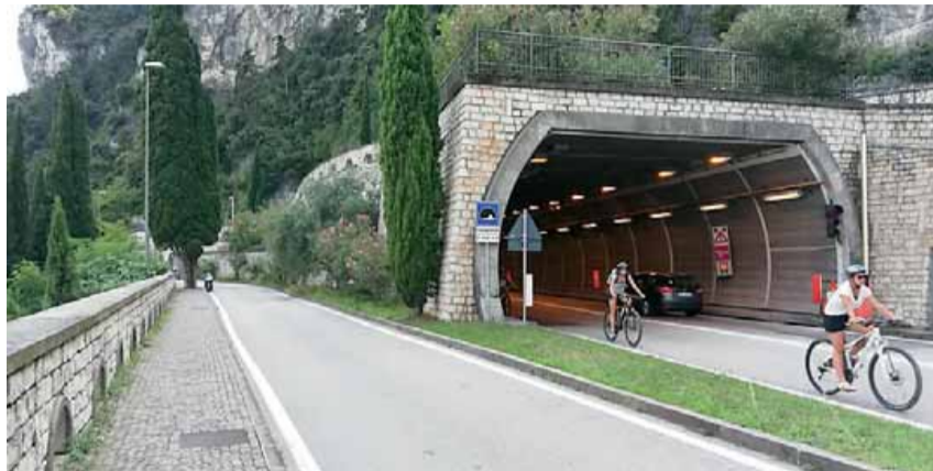
Ciclisti in uscita dalla galleria Casagranda: con la ciclabile non si passerà più dentro il tunnel
