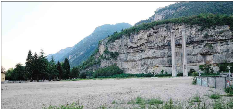
L'area ex Italcementi con le due ciminiere dopo l'intervento di bonifica realizzato da Piedicastello spa (Cooperazione)
