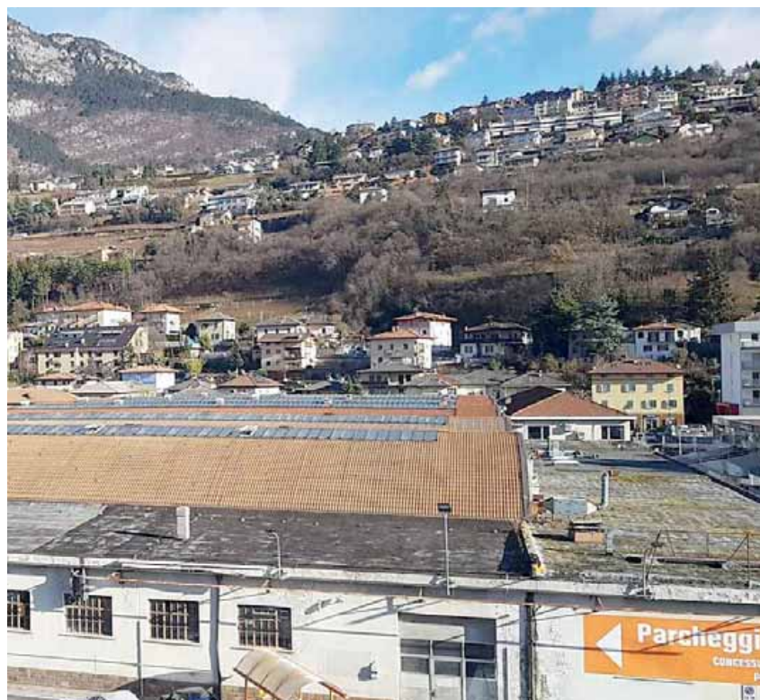
La parte vecchia del complesso sarà recuperata e destinata a uffici, mentre quella più recente sarà demolita
