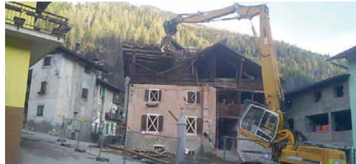
• La ruspa al lavoro in via Acquedotto di Strembo
