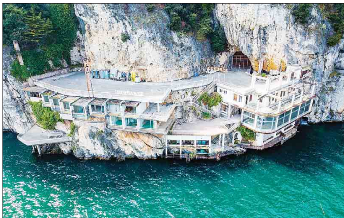
Una bella immagine aerea dell'attuale complesso della Casa della Trota, tra Riva e Limone
