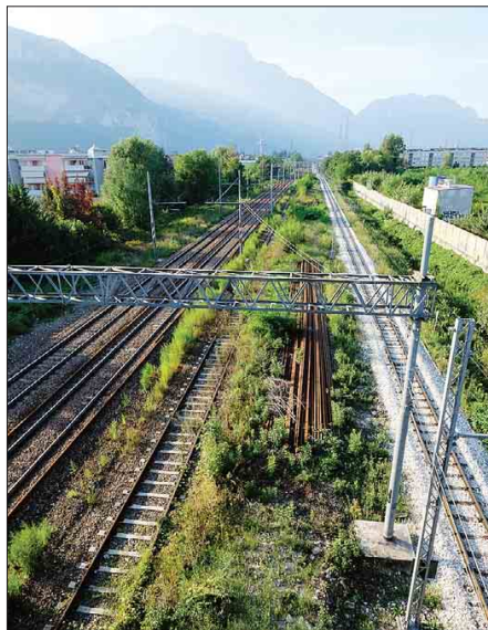
L'area dell'interramento dei binari della ferrovia in direzione nord
