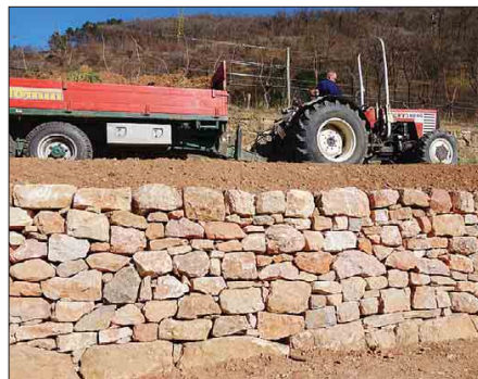
Muro a secco della Scuola della pietra
