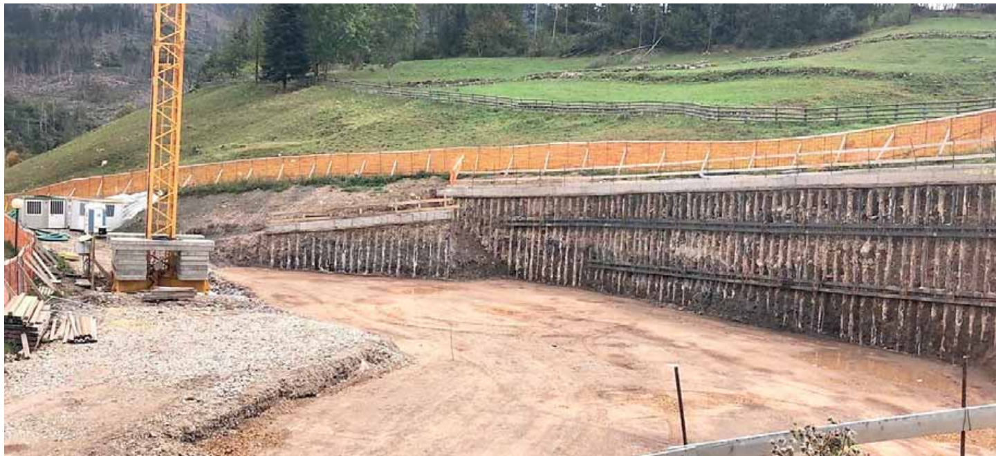
• Le opere di contenimento realizzate a Baselga di Piné per la nuova biblioteca intercomunale
