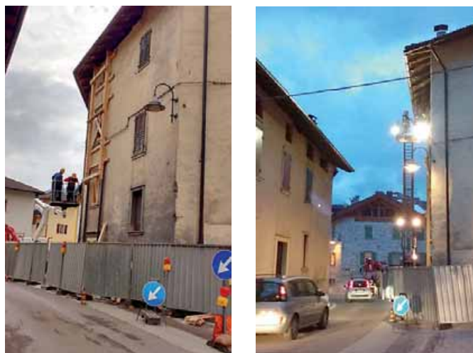
• Gli interventi in corso alla stretta di Javrè
