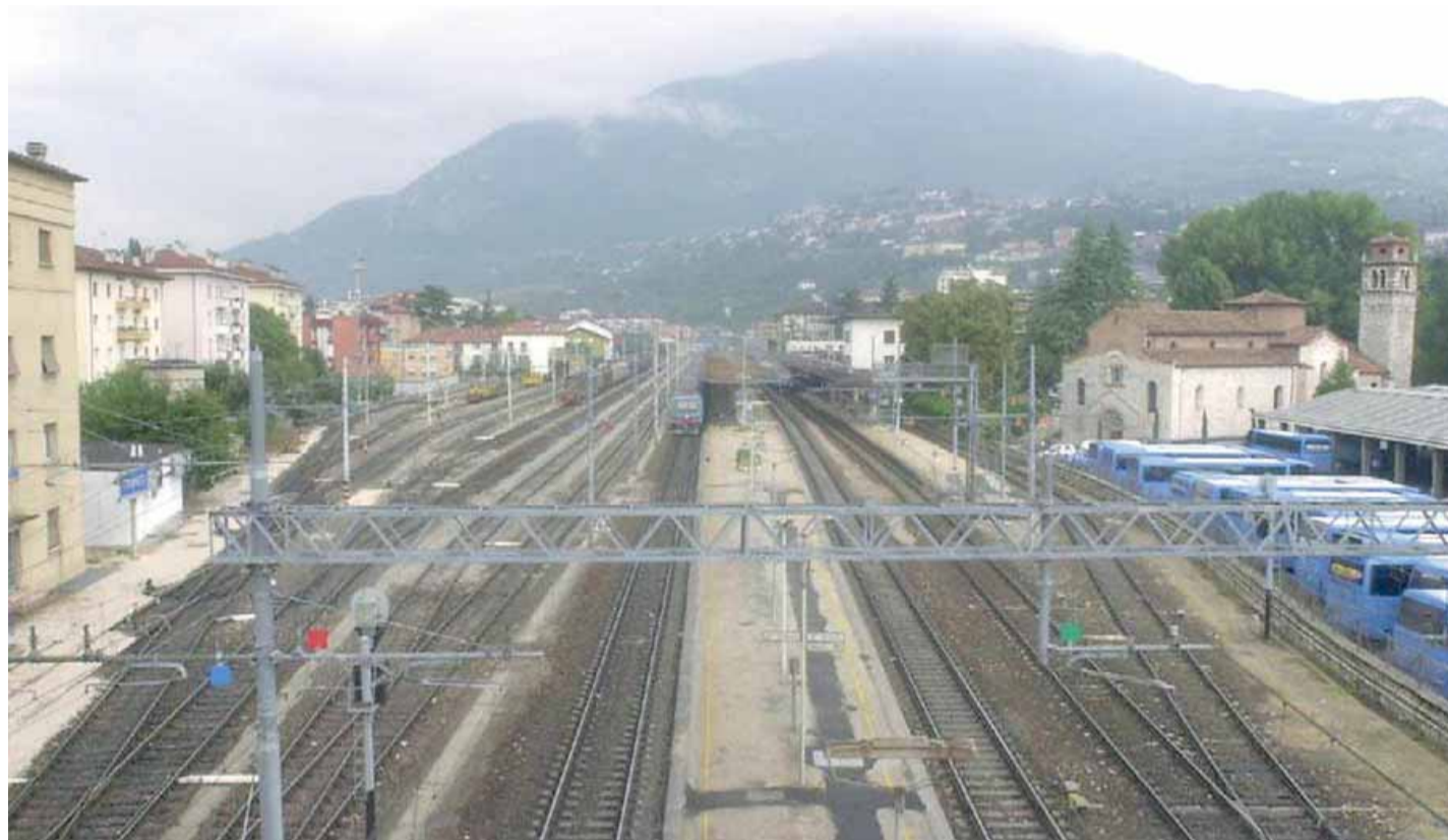
• La ferrovia del Brennero all'altezza della stazione di Trento: qui l'area è larga una sessantina di metri
