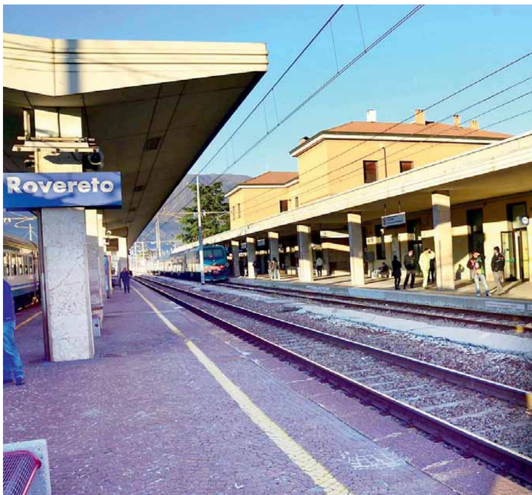
• Stazione e binari: una barriera fisica insuperabile che ha separato Rovereto da Sacco e S. Giorgio (FOTO FESTI)
