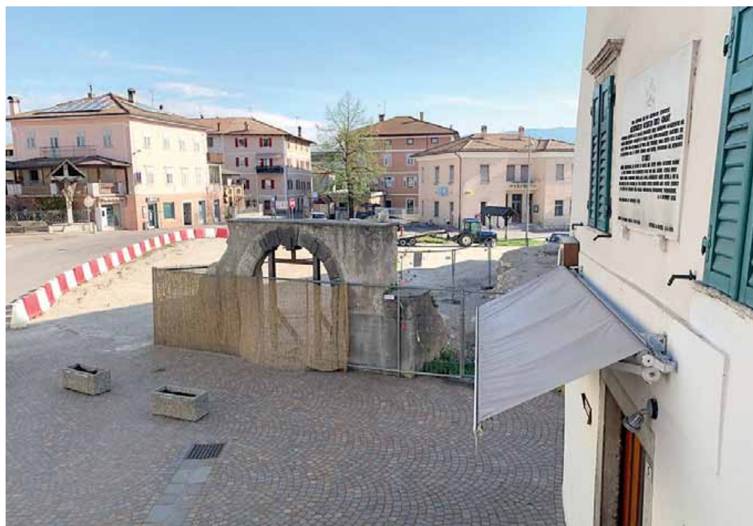
• Lo spazio recuperato a Romeno dopo l'abbattimento di un edificio fatiscante
