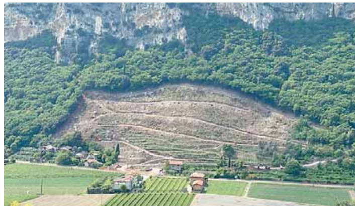
• Il cantiere sulla parete orientale del Brione per creare il vallo tomo
