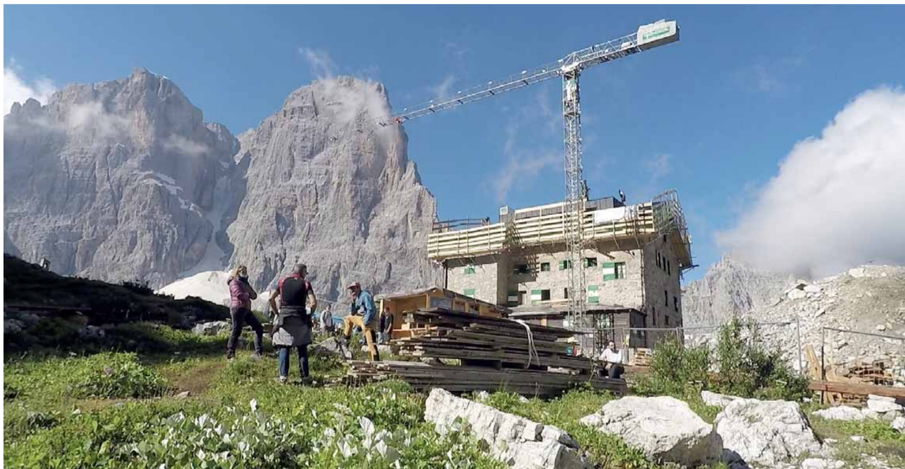
• Il cantiere del rifugio Alberto e Maria ai Brentei nella classica inquadratura con il Crozzon di Brenta sullo sfondo. I lavori sono stati affidati dal Cai di Monza alla Legno House di Caldonazzo
