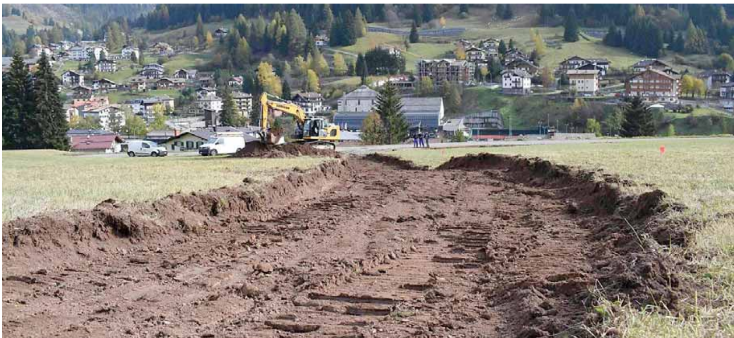
• Ruspe al lavoro per tracciare la pista di esbosco
