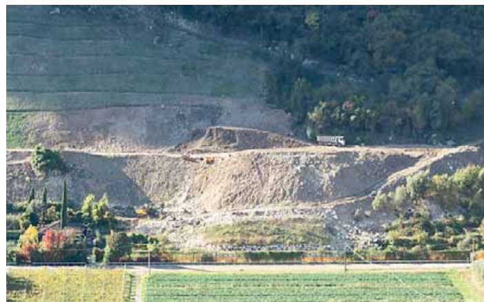
• Un dettaglio dei lavori fermi al vallo tomo di Linfano
