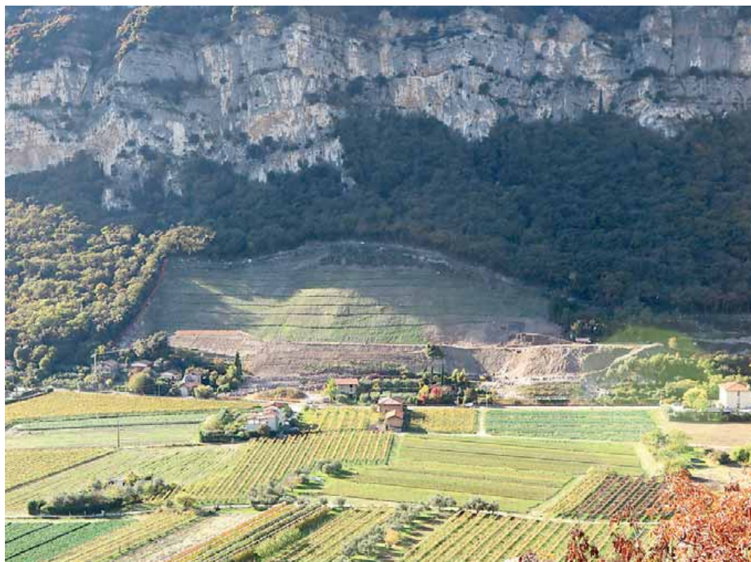
• Il vallo tomo in costruzione al Linfano, alle pendici del monte Brione FOTO FABIO GALAS
