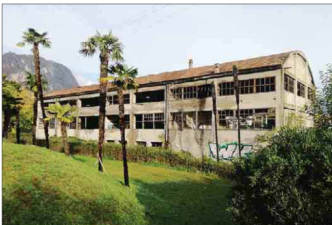
Il relitto industriale dell'ex mobilificio all'interno dell'area ex Cattoi
