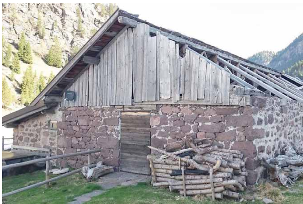
• Una parte della struttura di Malga Lagorai: quale sarà il suo futuro?
