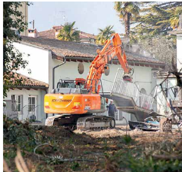
Le ruspe al lavoro all'interno del cantiere di Villa San Pietro
