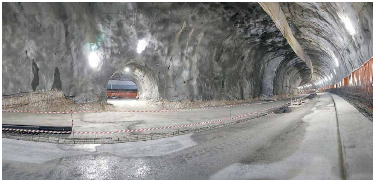
Il tunnel principale e, a sinistra, quello di servizio; in basso il pompaggio dell'acqua; nella parte alcuni momenti della visita di ieri (Fotoshop Professional)
