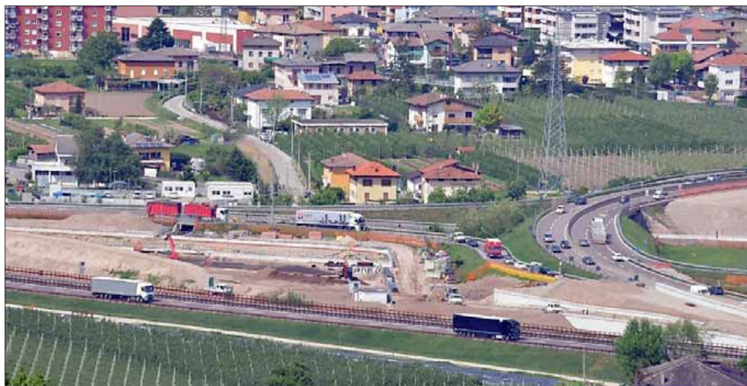
Il cantiere di Emaprice spa di realizzazione dello svincolo tra statale 12 provinciale 235 per l'interporto (foto Panato)
