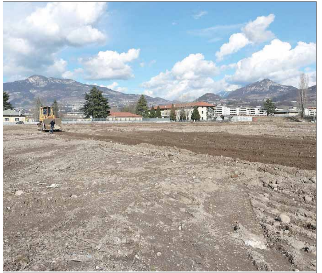
I terreni di via al desert dove dovrà essere costruito il Nuovo Ospedale del Trentino
